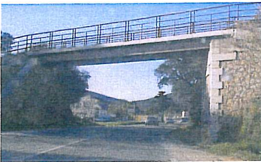
Pont de l'ancienne voie ferrée
