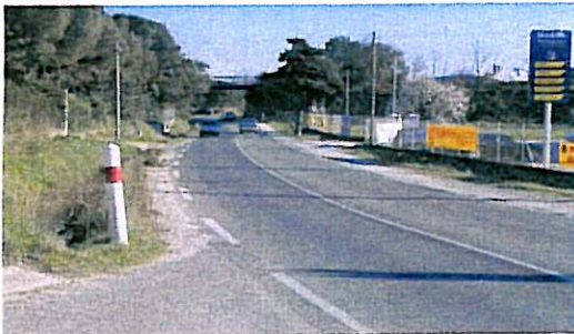
Carrefour de Maudroume et pont ancienne voie ferrée
