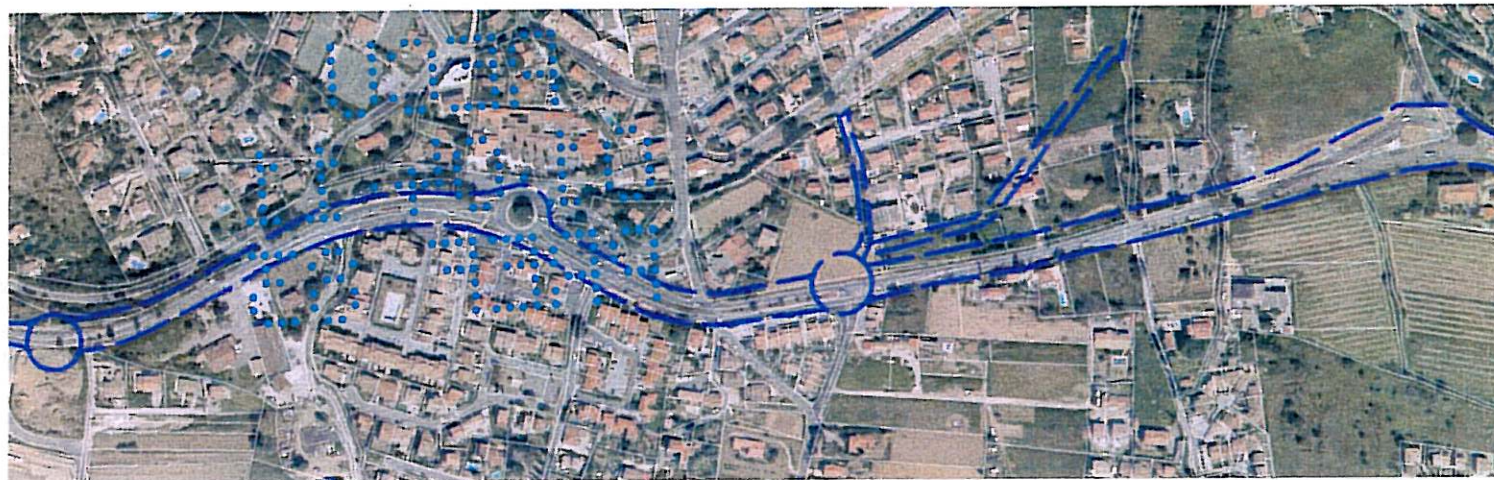
L'E.R. de la RD 559 et son insertion dans le parcellaire entre le rond point du Niel et celui de Bénat
