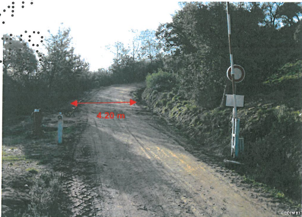
Voie de bouclage réservée aux véhicules de lutte incendie entre le Cros de Carles et le Mont des Roses
