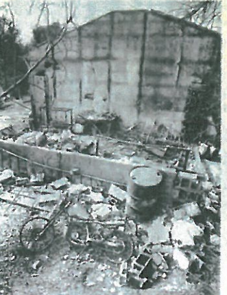
Celle des Blanches, entièrement détruite
